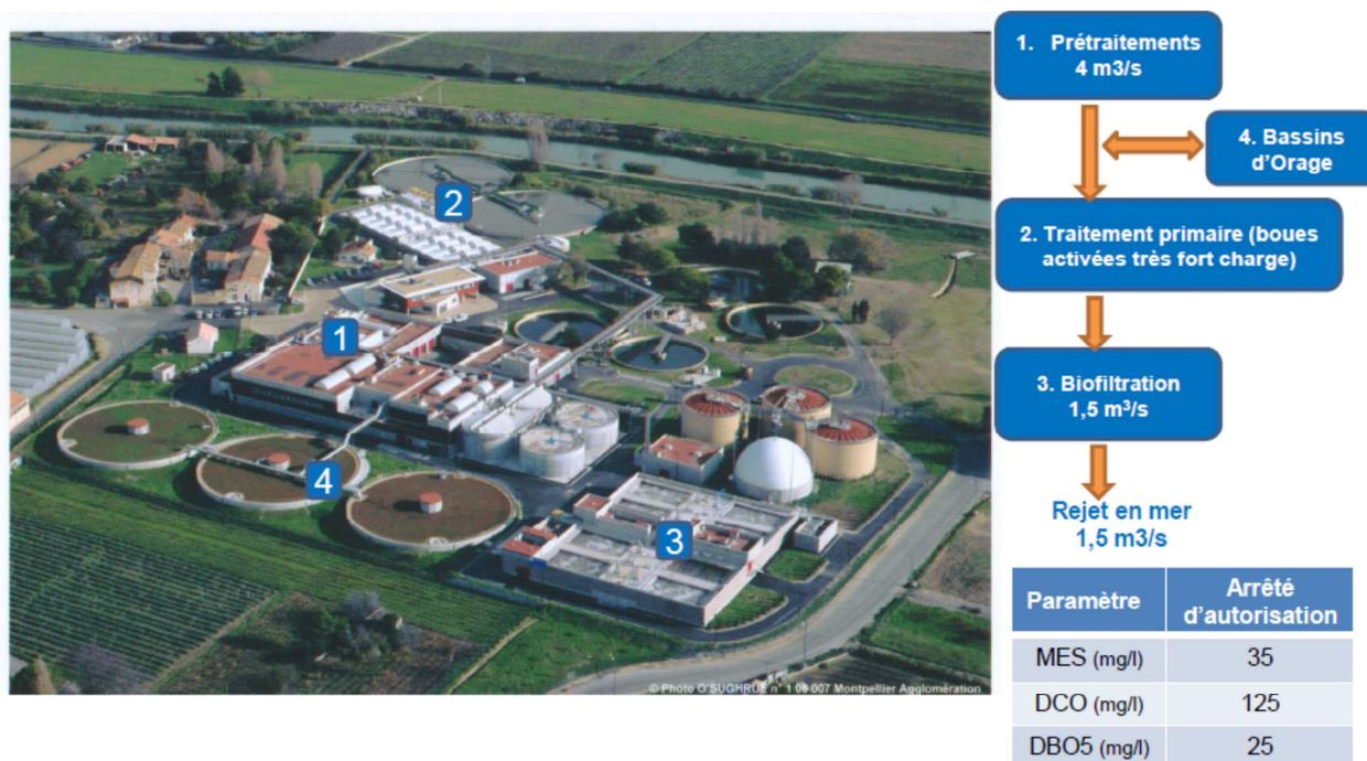
La qualité du traitement s'apprécie à la mesure des paramètres MES (Matières en Suspension), DCO (Demande Chimique en Oxygène) et DBO5 (Demande Biologique en Oxygène). Ce sont des paramètres caractéristiques des eaux usées, permettant de caractériser la pollution contenue dans ces eaux.
